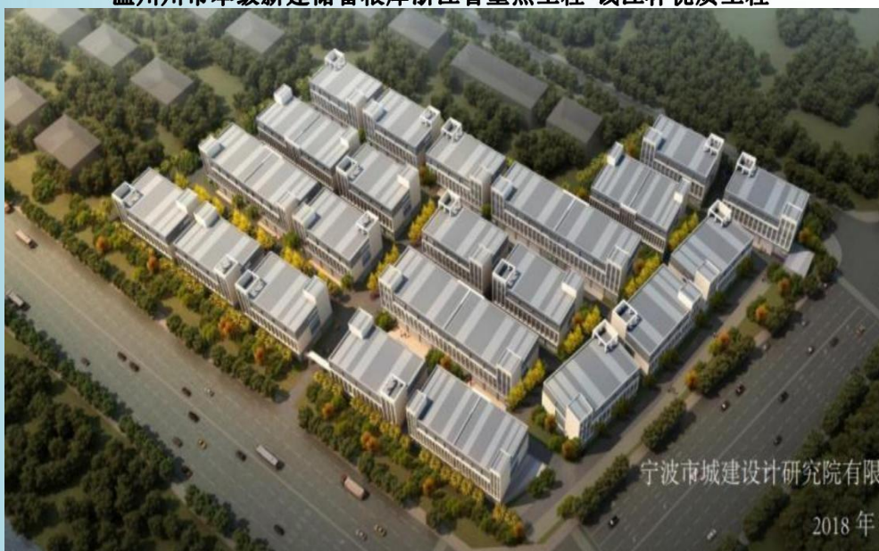
浙江卓诗尼鞋业有限公司厂房新建工程
