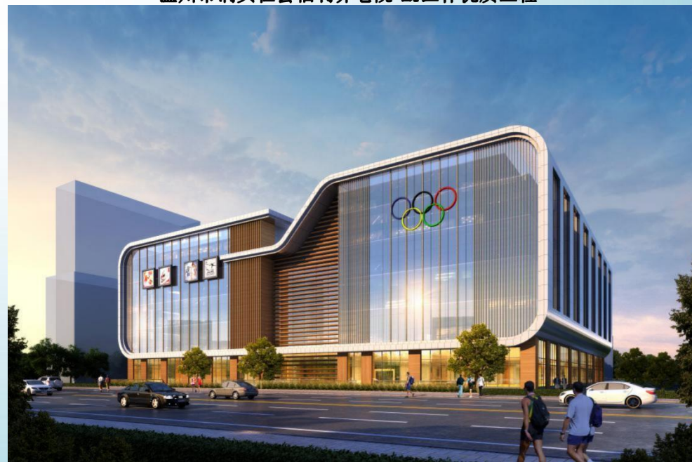
瑞安市体育馆项目三期工程-钱江杯优质工程
